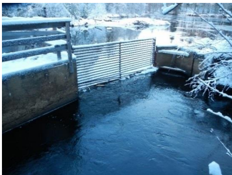
Figur 6. Grind med horisontella rör installerad uppströms intaget
