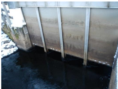
Figur 5. Intaget med intagsluckorna lyfta över vattenytan
